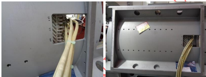
Obrázek 28 – Ukázka z kontroly vyvedené kabeláže
