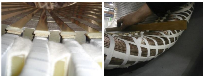
Obrázek 23 – Ukázka z kontroly izolace a drážkových klínů
