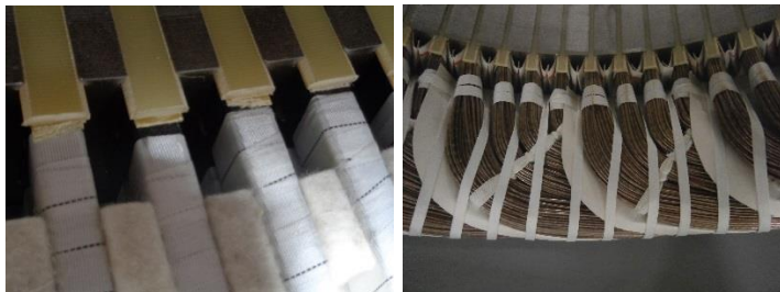
Obrázek 22 – Ukázka z kontroly proložení izolací
