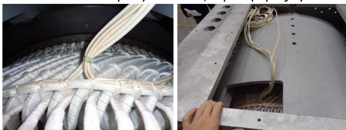
Obrázek 27 – Ukázka z kontroly umístění tepelných ochran atd.
