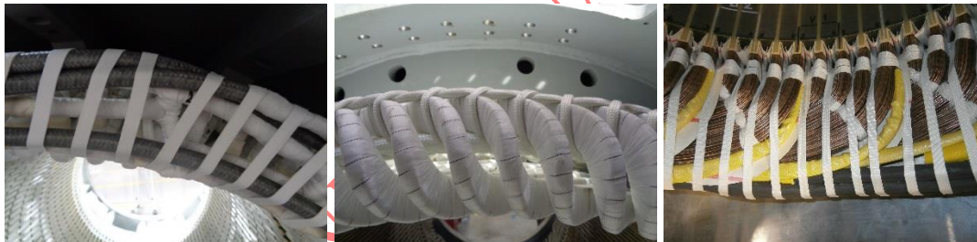
Obrázek 24 – Ukázka z kontroly obšití čel vinutí
