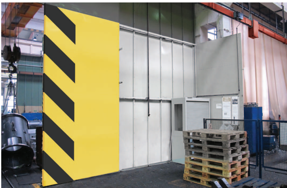
Panel s bezpečnostním značením u průchodu mezi halami
