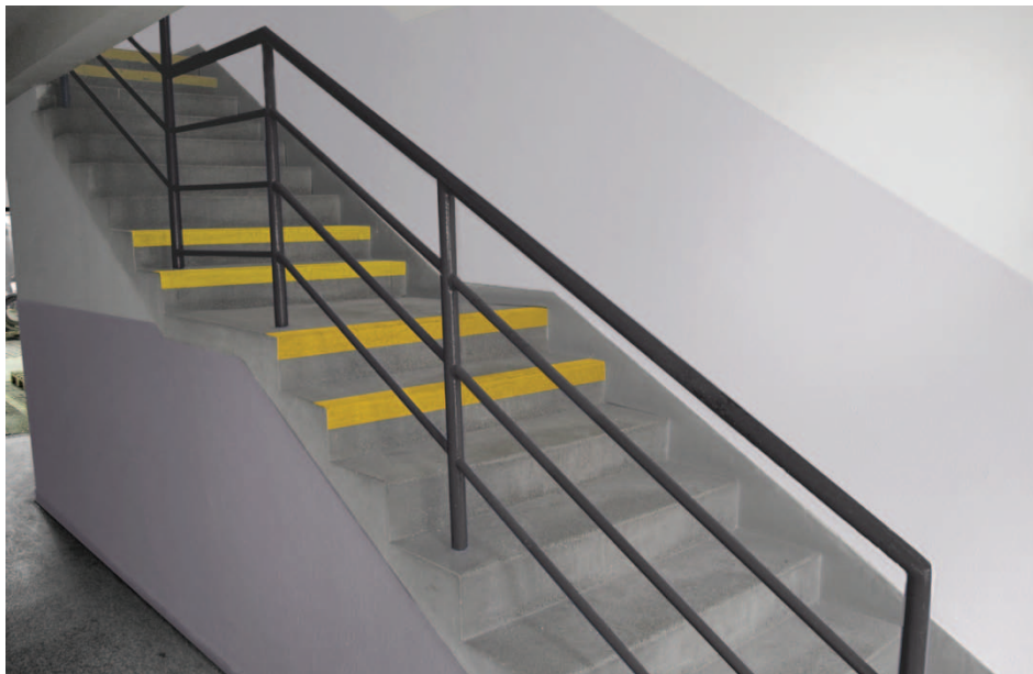
Zábradlí schodiště - tmavě šedá barva
